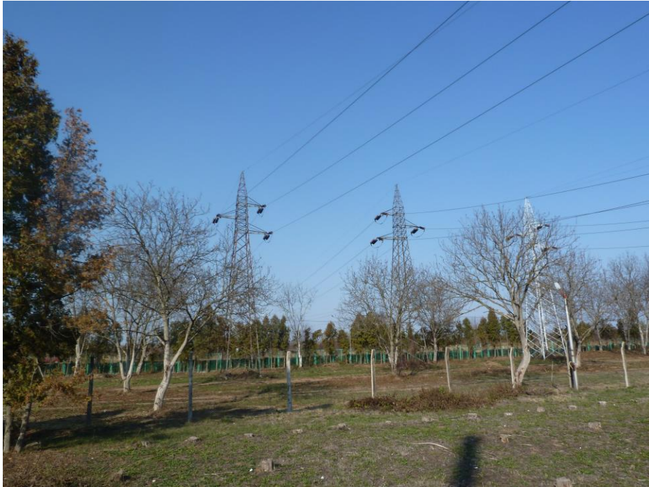
Slika 10.20: Fotografija dalekovoda na izlazu iz postrojenja 110 kV TE "Morava"
